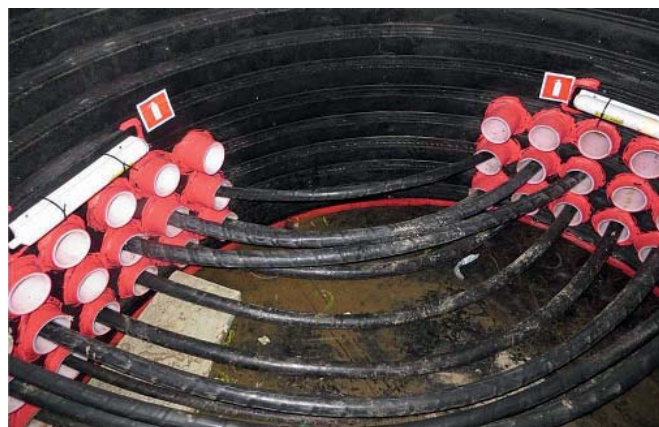
Рис. 7. Колодец в месте поворота трассы блочной канализации КЛ 10 кВ
