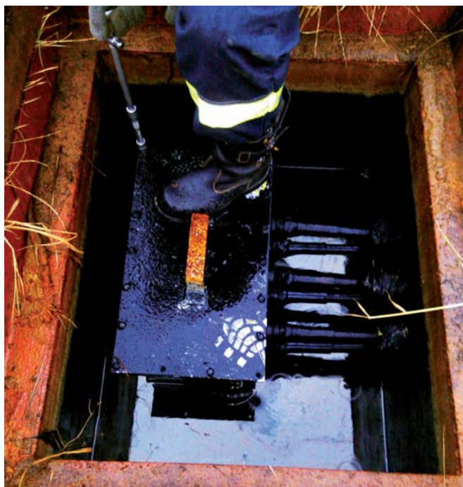
Рис. 6. Вскрытие коробки транспозиции в «компактном» колодце транспозиции
