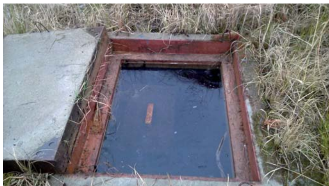
Рис. 6. Вскрытие коробки транспозиции в «компактном» колодце транспозиции
