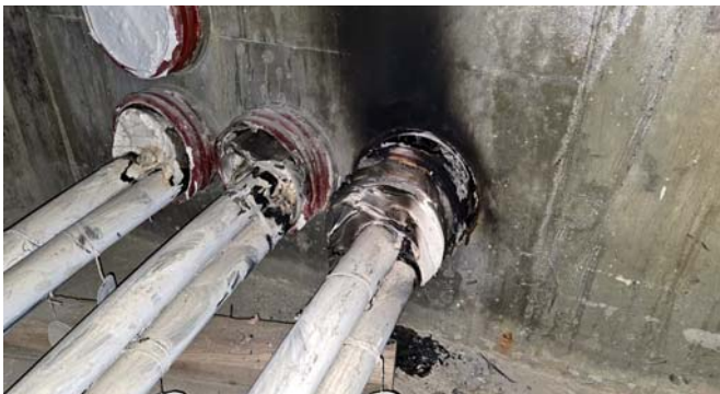
Рис. 5. Последствия неверного выбора взаимного расположения кабелей
