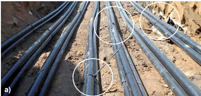
Рис. 5. Последствия неверного выбора взаимного расположения кабелей
