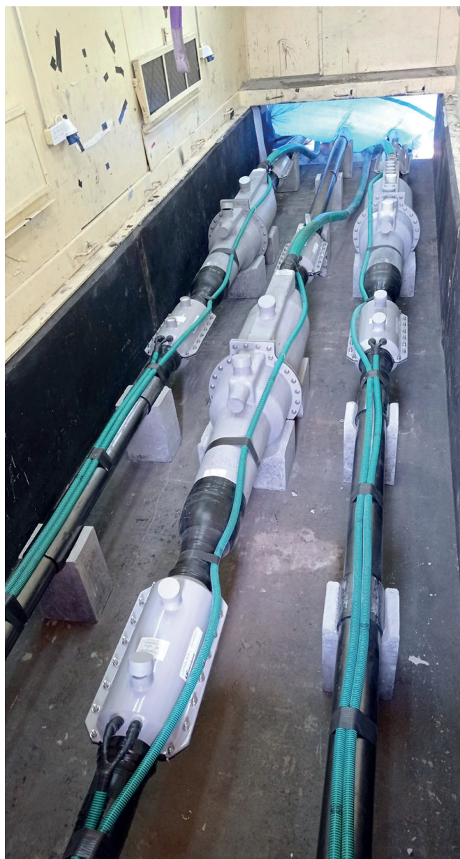
Рис. 5. Кабельные муфты с мониторингом ЧР
