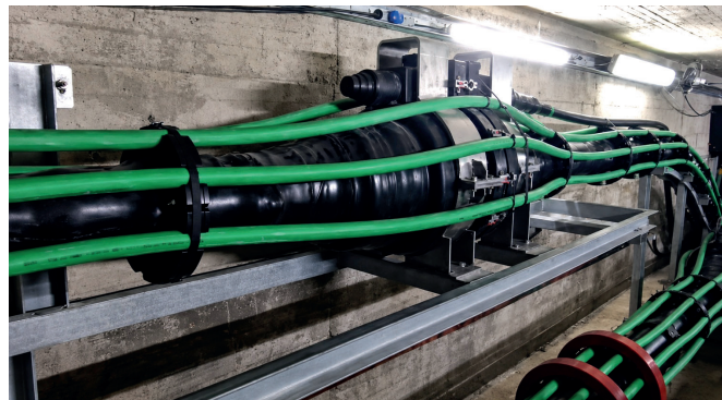
Рис. 4. Компенсация магнитного поля кабелей: а) общий вид кабелей; б) соединительная муфта
