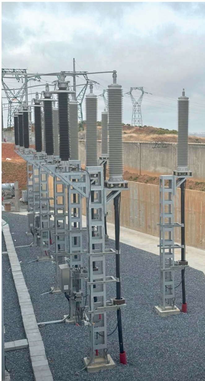
Рис. 3. Резервная муфта и резервный кабель
