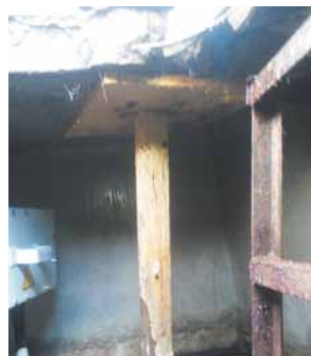
Обрушение потолка бетонного колодца
