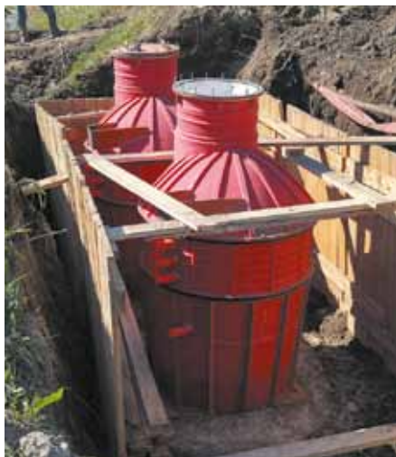
Монтаж полимерных колодцев
